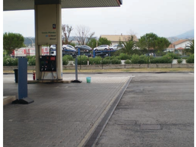
Impianto di carburante, Italia
