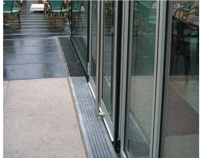
Installazione sulle terrazze
