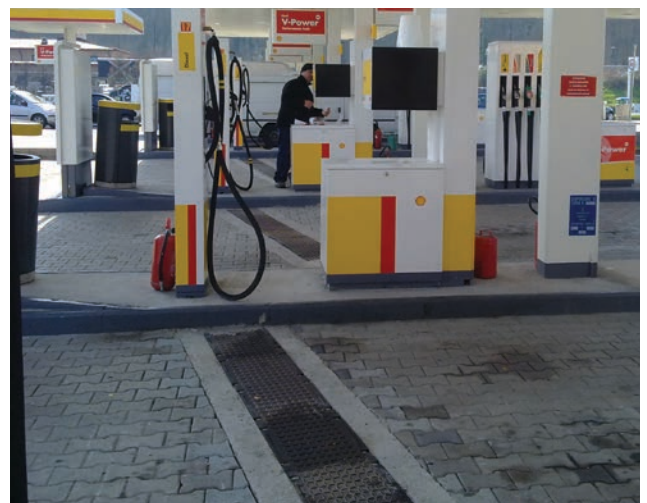
Impianto carburante, Autostrada A1, Italia
