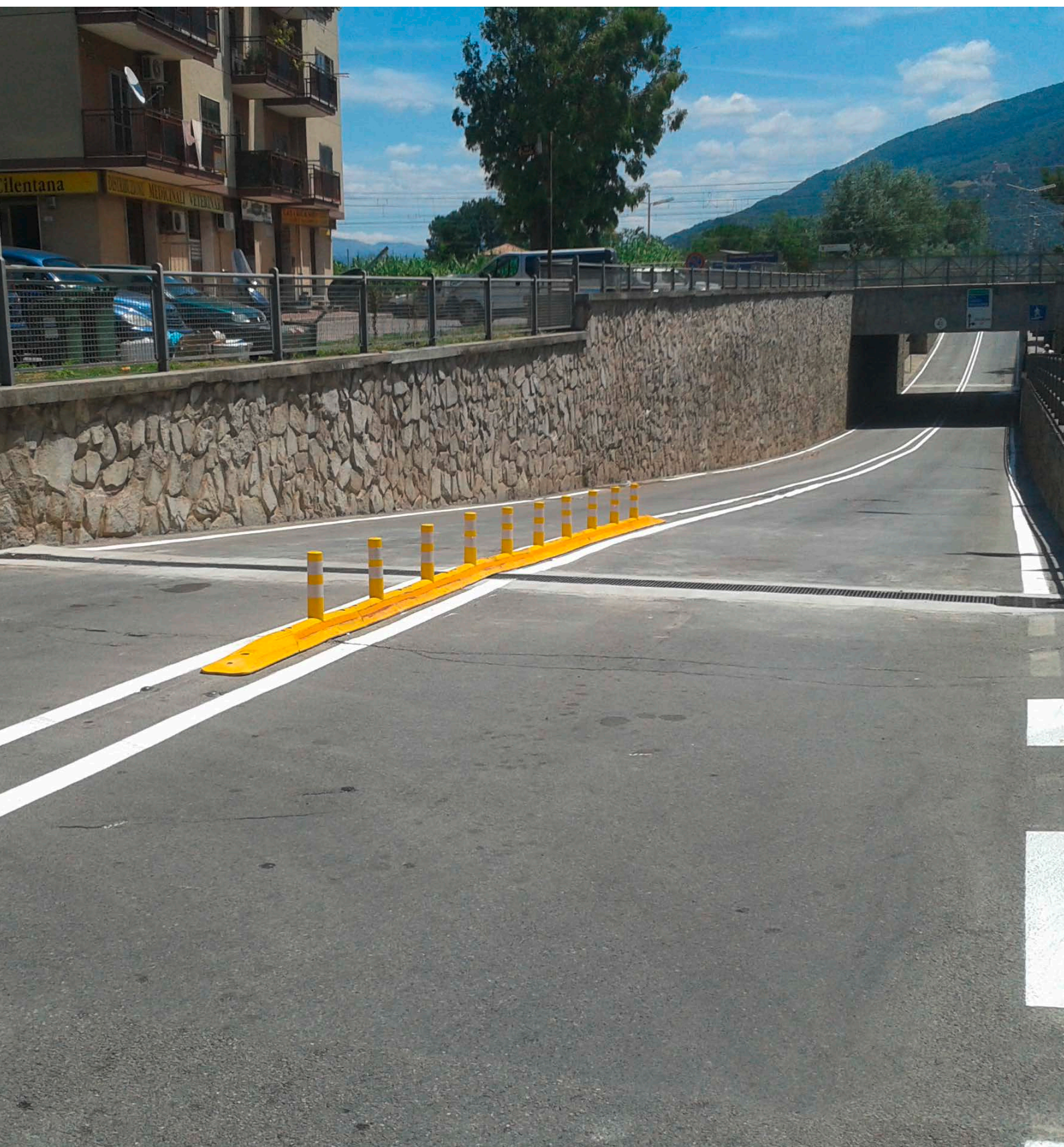
Sottopasso ferroviario, Capaccio Scalo (SA)
